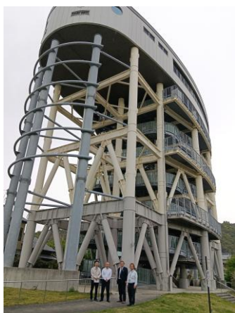
佐賀地区津波避難タワー
