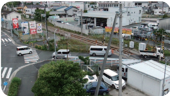
危険な駅東踏切周辺
