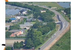
木津水源地 (第1・第2)
