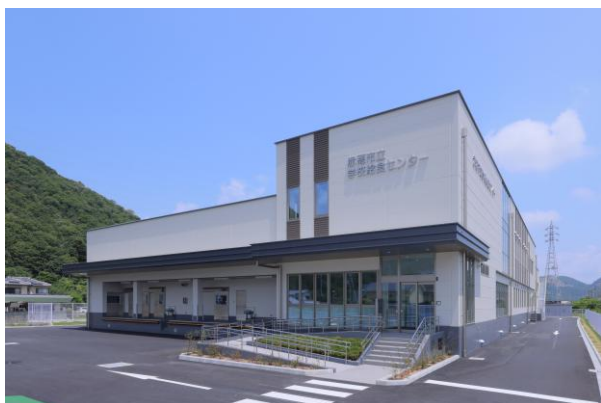
新学校給食センター（令和7年8月竣工）
