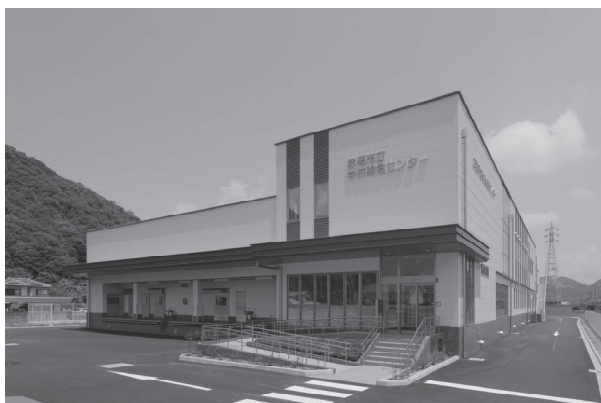
新学校給食センター（令和7年8月竣工）
