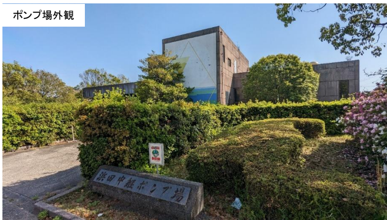
ポンプ場外観
