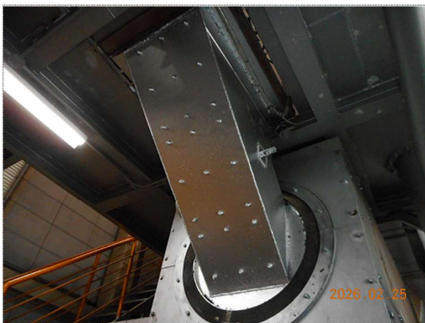
② トロンメル 入口シュート下面ケーシング
