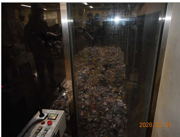
④ ごみピット状況 中央制御室から見る
